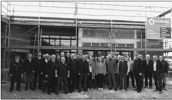
Vor dem Eingang des Feuerwehrneubaus versammelten sich Bürgermeister Thorsten Weber, der Gemeinderat und Mitglieder der freiwilligen Feuerwehr mit ihrem Kommandanten Karl Wendel, Stellvertreter Josef Bangert und Kreisbrandmeister Jörg Kirschenlohr. Im Oktober soll der Bau fertiggestellt sein.
