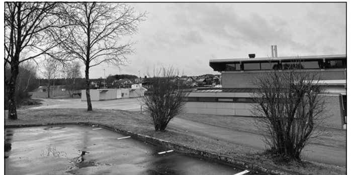
Das Bild zeigt den Bereich eines möglichen Standorts für die künftige Heizzentrale - in der Nähe der jetzigen Zentrale in der Limbacher Mehrzweckhalle.
